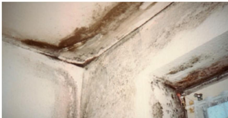
*Wärmebrückenbedingter Schimmelbefall in einer Altbauwohnung*
